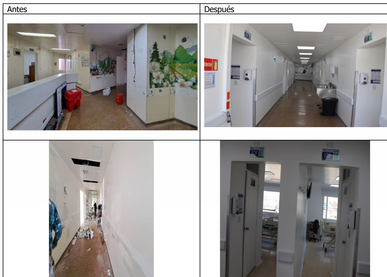
7. Mantenimiento Infraestructura Salas de Cirugía
