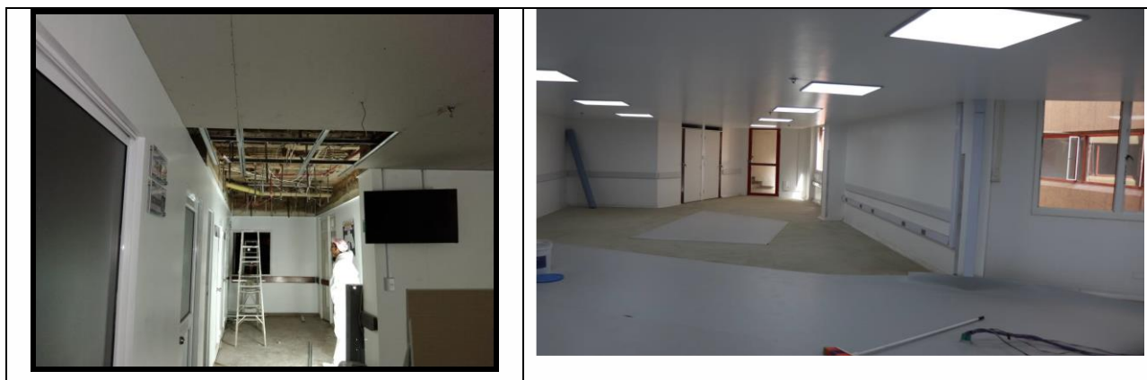
6. Mantenimiento Infraestructura Servicio Unidad De Cuidado De Intensivo Pediátrico "UCIP".
